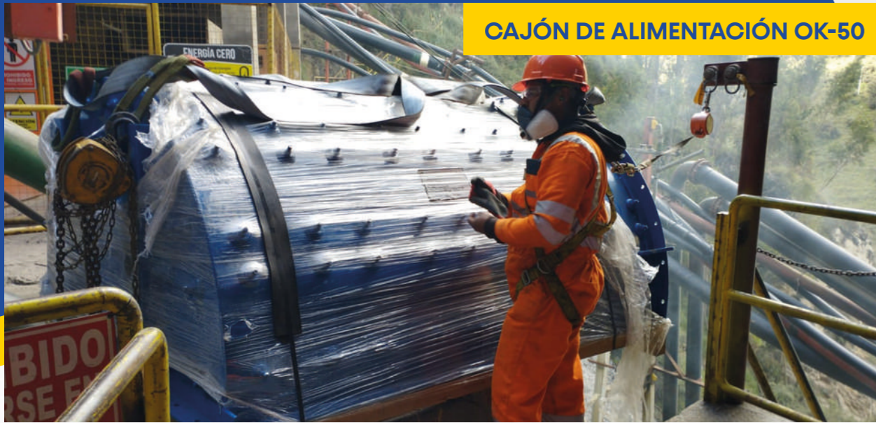
MONTAJE DE CAJÓN DE ALIMENTACIÓN OK-50.
